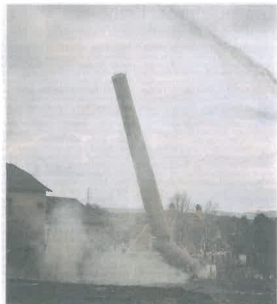
Stabil: Der Schornstein knickte bei der Sprengung kaum ein. Foto: Michael Kießling
